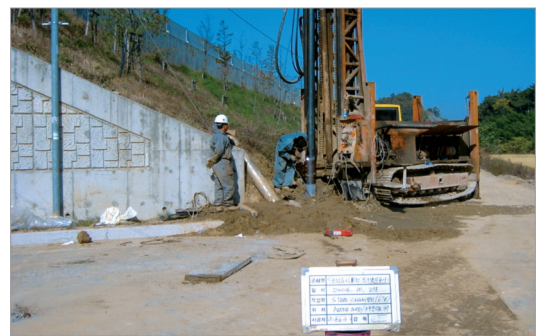
심매용 보링홀 작업 모습 Boring Works for Deep Anode Bed
