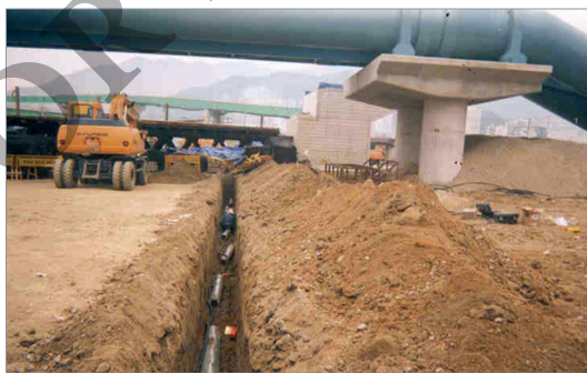
천매용 고규소주철양극 설치 모습 Installation of Anodes for Shallow Anode Bed
