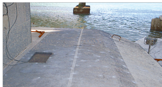
티타늄 메쉬 양극 설치 모습 View of Installing Titanium Mesh Anode
