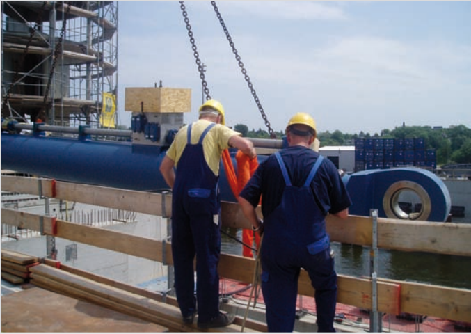
Installation der Hydraulikzylinder für die Klappbrücke Lübeck, Deutschland
