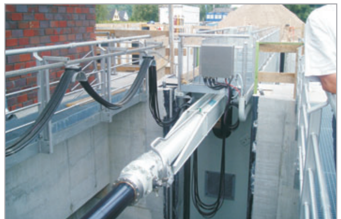
Horizontales Schiebetor der Tatenberger Schleuse mit hydraulischem Zylinder mit 13 m Hub Horizontal shift gate of ship lock Tatenberg with hydraulic cylinder with 13 m stroke
