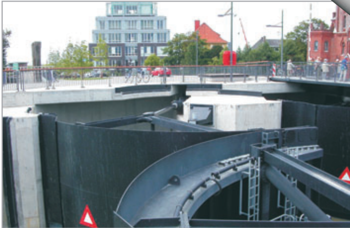
Drehtor der Fischereihafenschleuse Wilhelmshaven Twist gate of sea port in Wilhelmshaven
