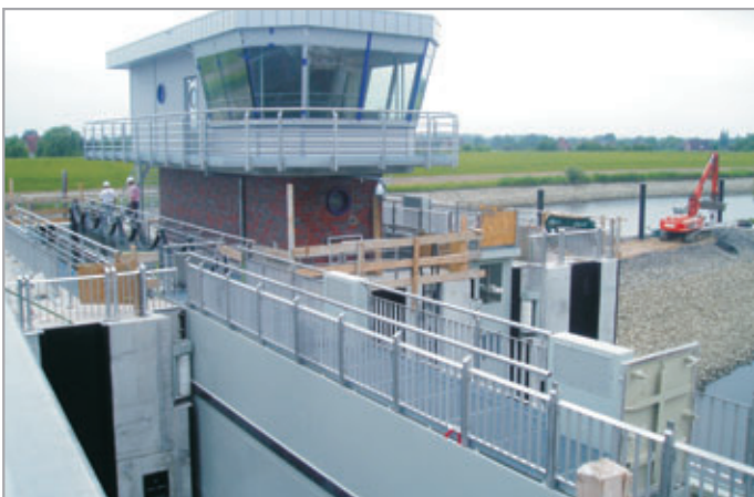
Horizontales Schiebetor der Tatenberger Schleuse mit hydraulischem Zylinder mit 13 m Hub Horizontal shift gate of ship lock Tatenberg with hydraulic cylinder with 13 m stroke
