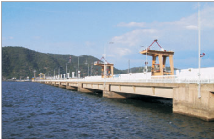
Donaustauwerk „Eisernes Tor“ 1, Serbien mit 2 Gigawatt Nennleistung
