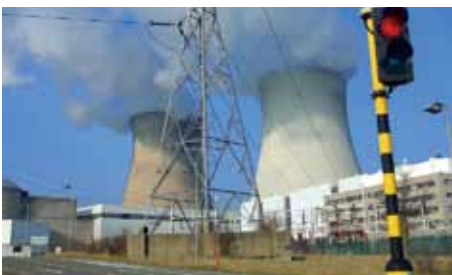
환경설비 (정수장, 폐수처리장, 하수처리장, 소각로)
